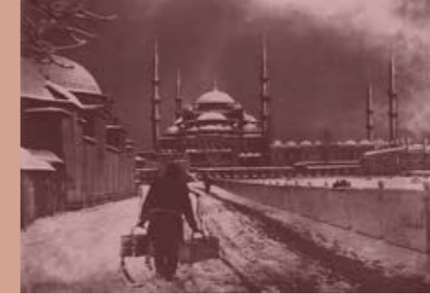
Sultan Ahmet Camii
